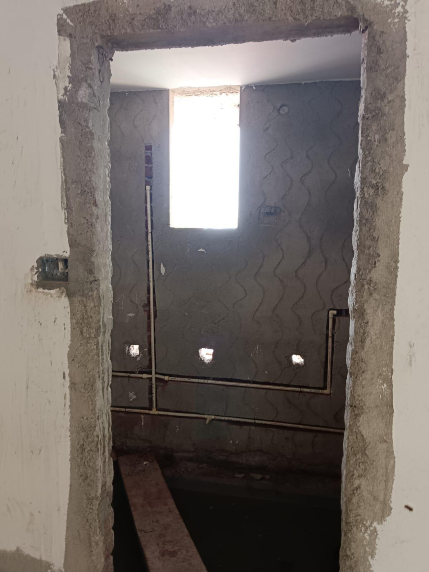
3 RD FL BATHROOM
