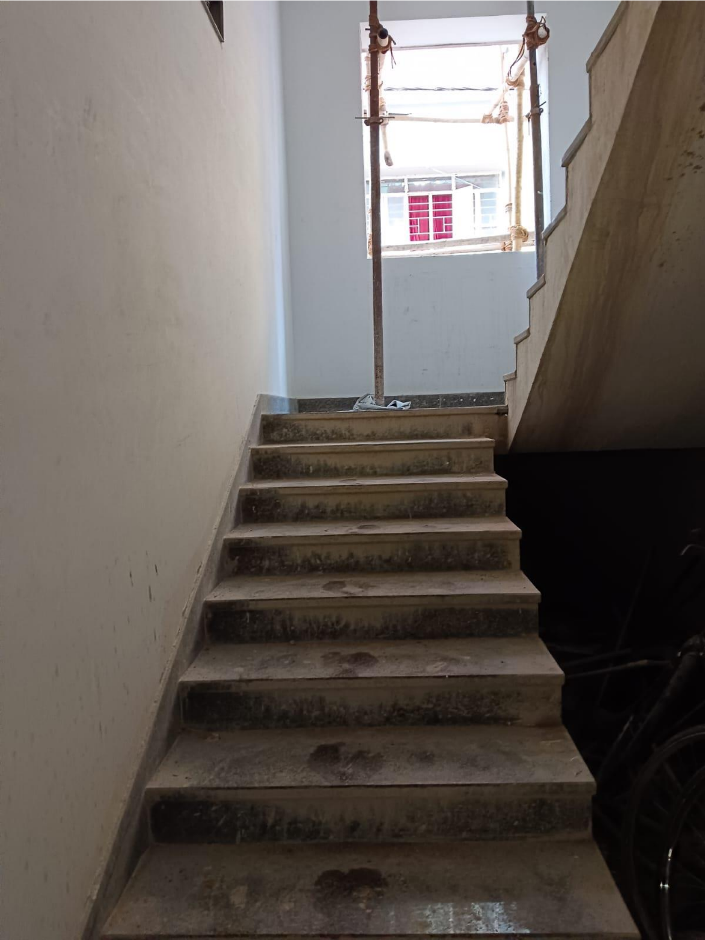
GR. FL. STAIR
