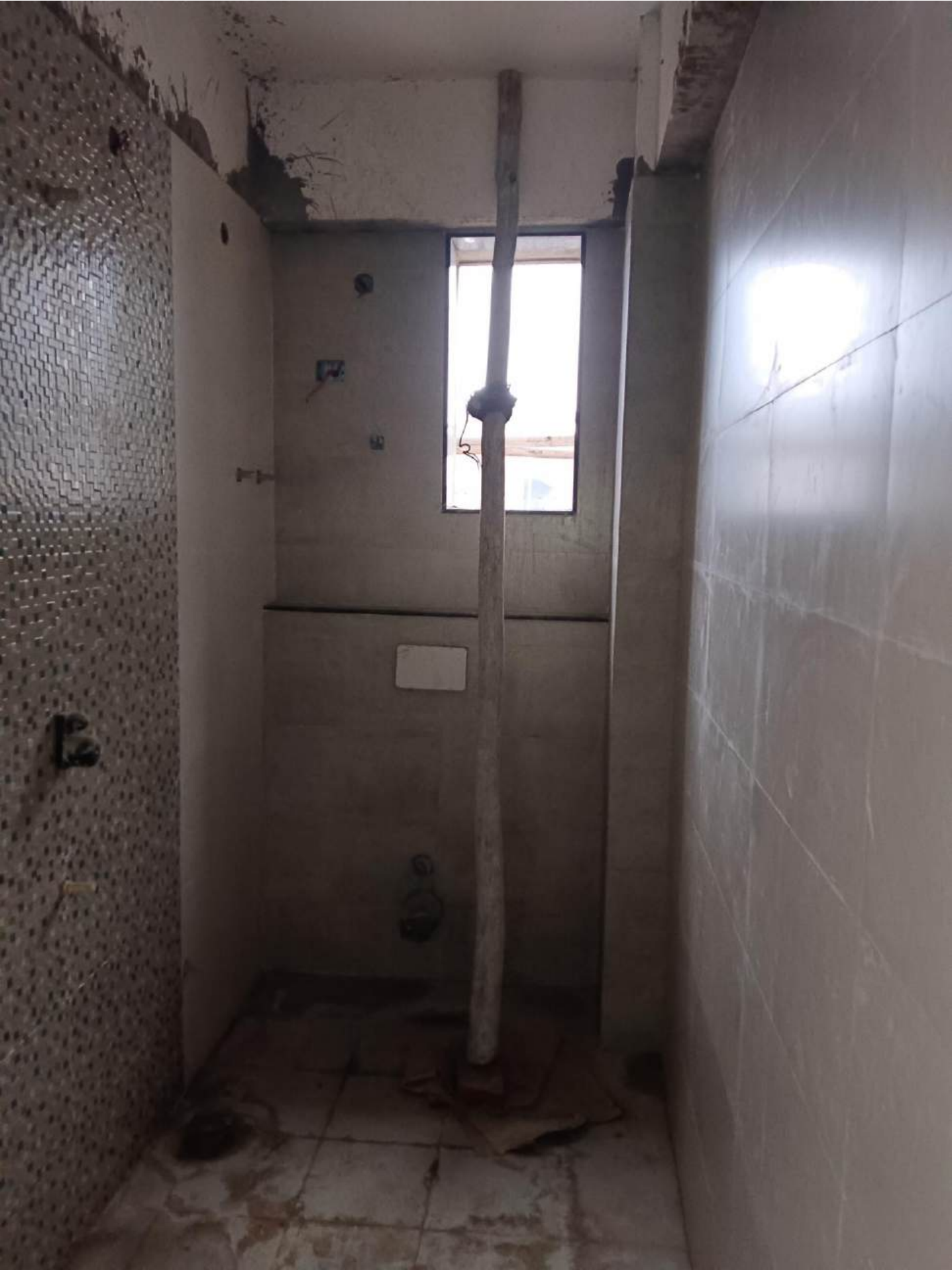
3 RD FL BATHROOM
