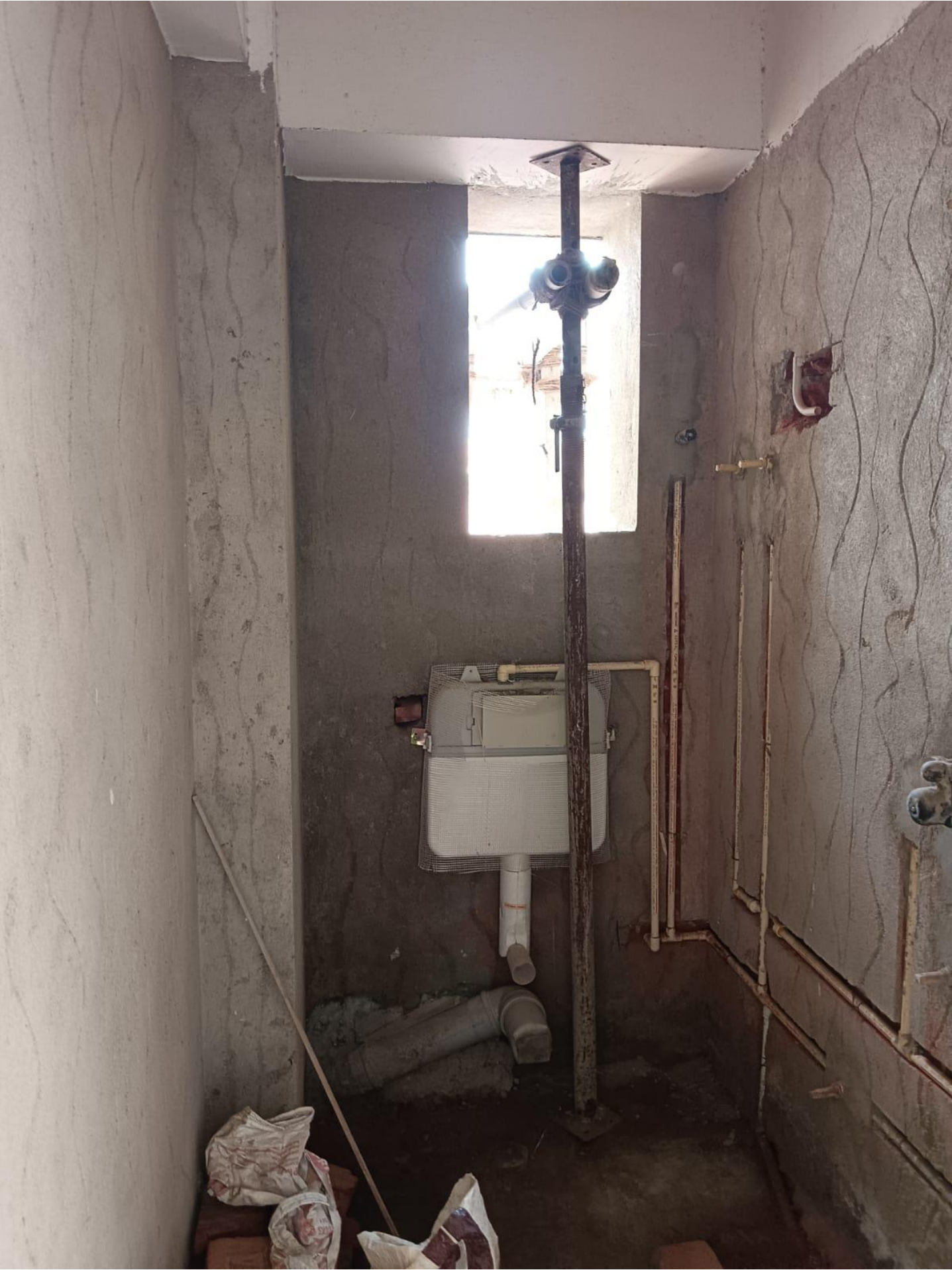
3 RD FL BATHROOM
