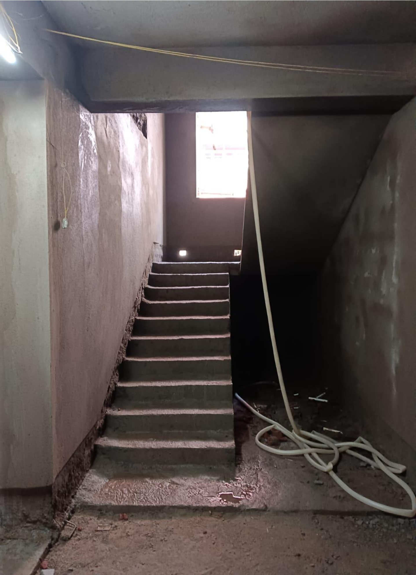
GR. FL. STAIR
