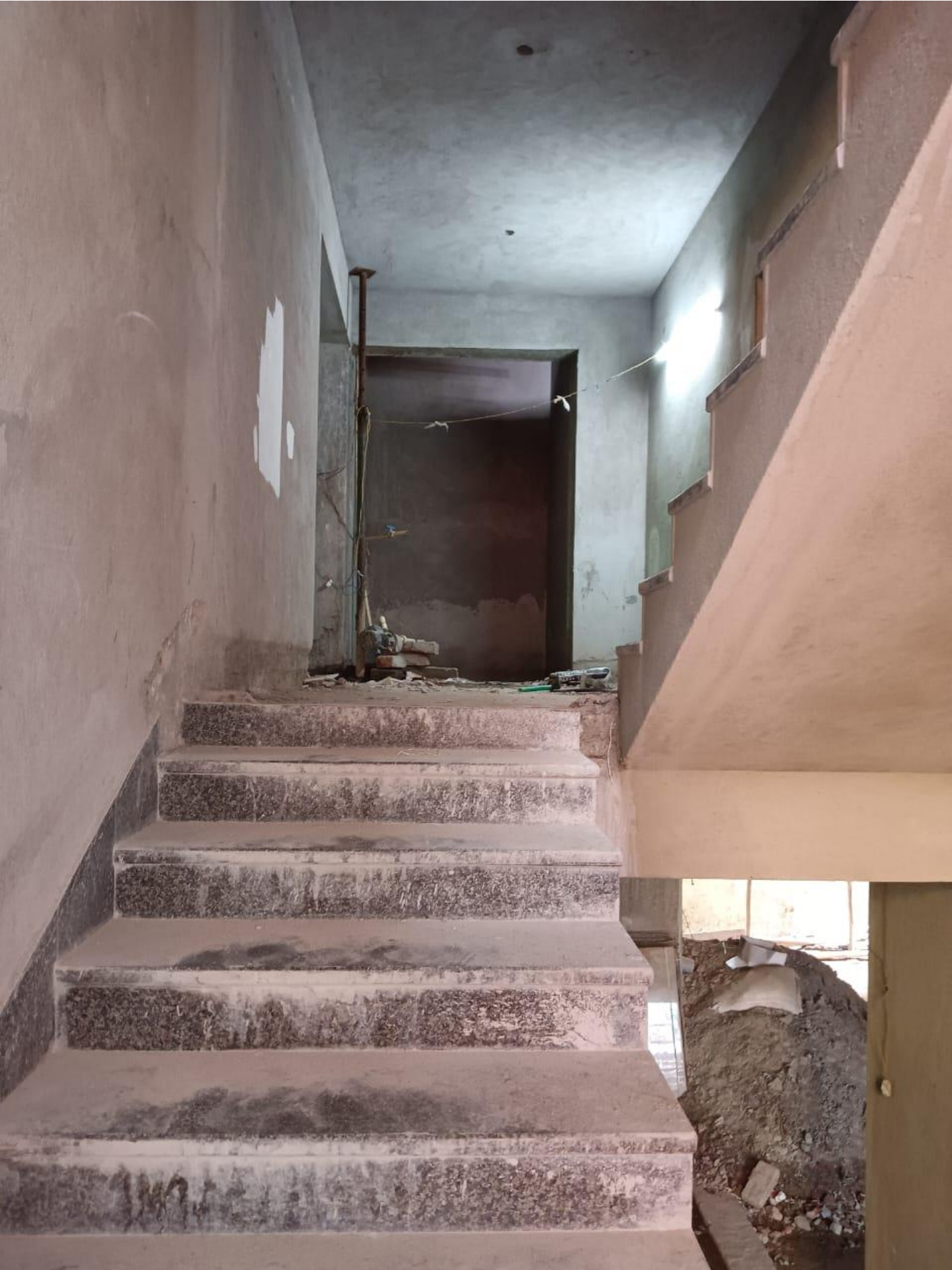
GR. FL. STAIR
