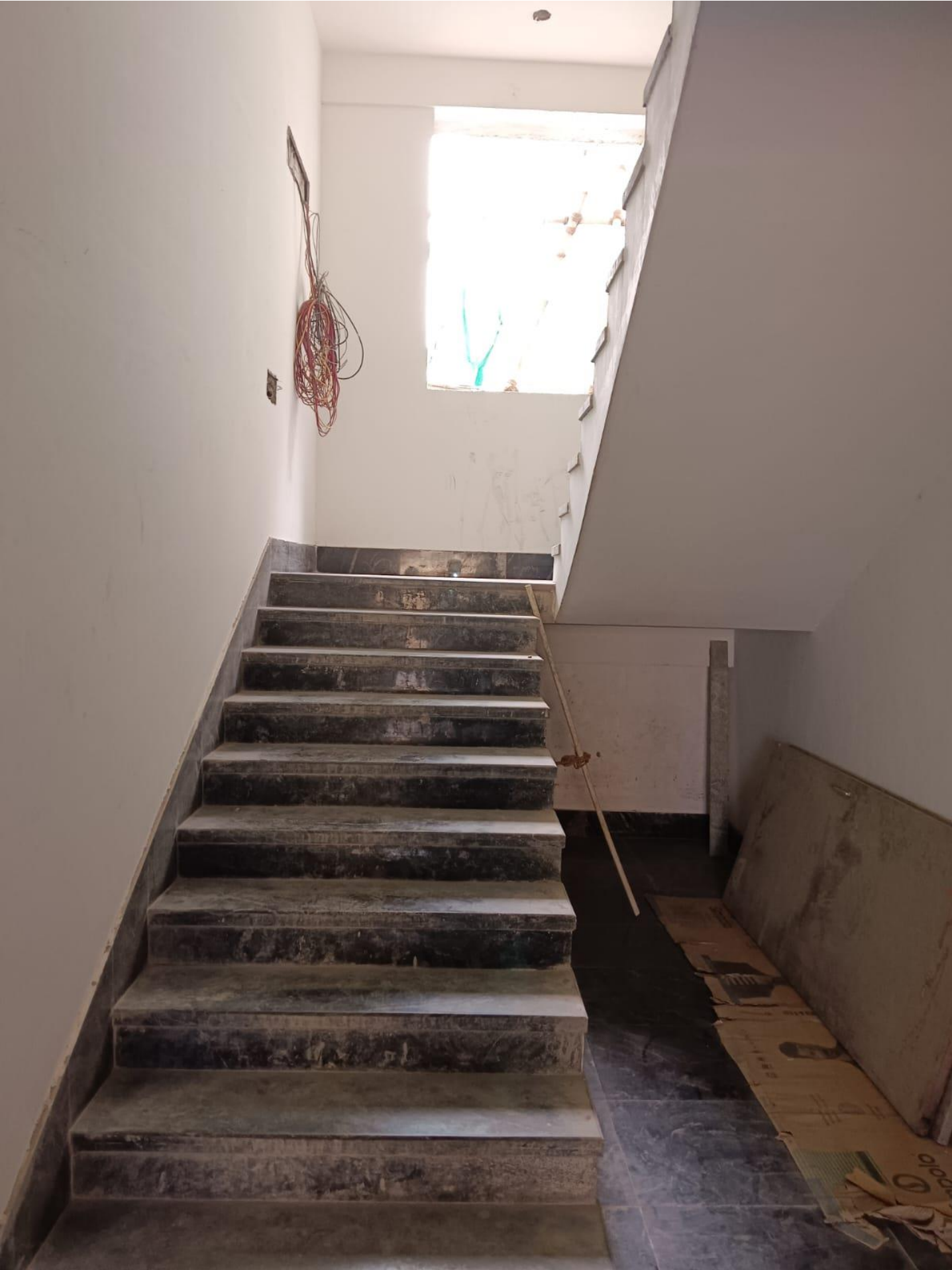
GR. FL. STAIR
