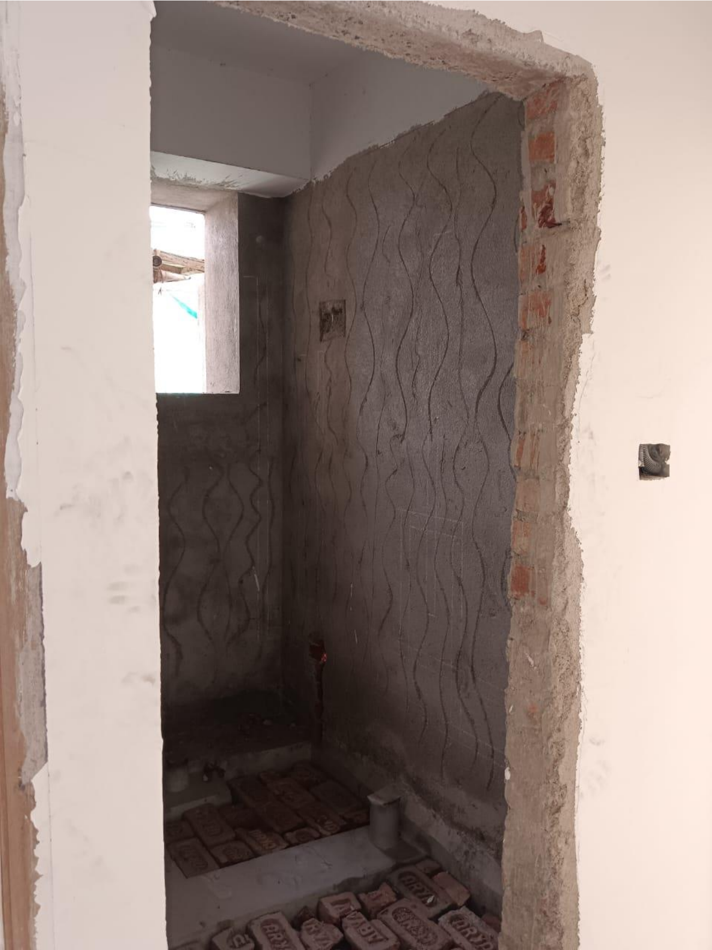
3 RD FL BATHROOM
